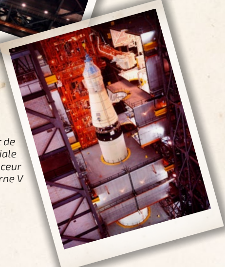
Le deuxième étage S-II est placé en position pour l'accouplement avec le premier étage S-IC
